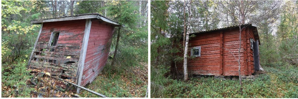
Kuva 11 Korttelin 5 purkukuntoiset rakennukset
