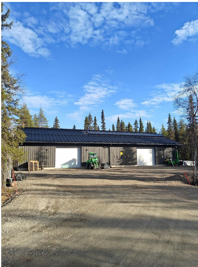
Kuva 16. Alueella sijaitseva huoltorakennus.
