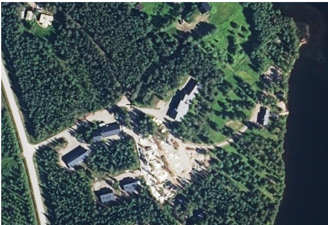
Kuva 3. Ilmakuva suunnittelualueelta. © Maanmittauslaitos 8/2025.
