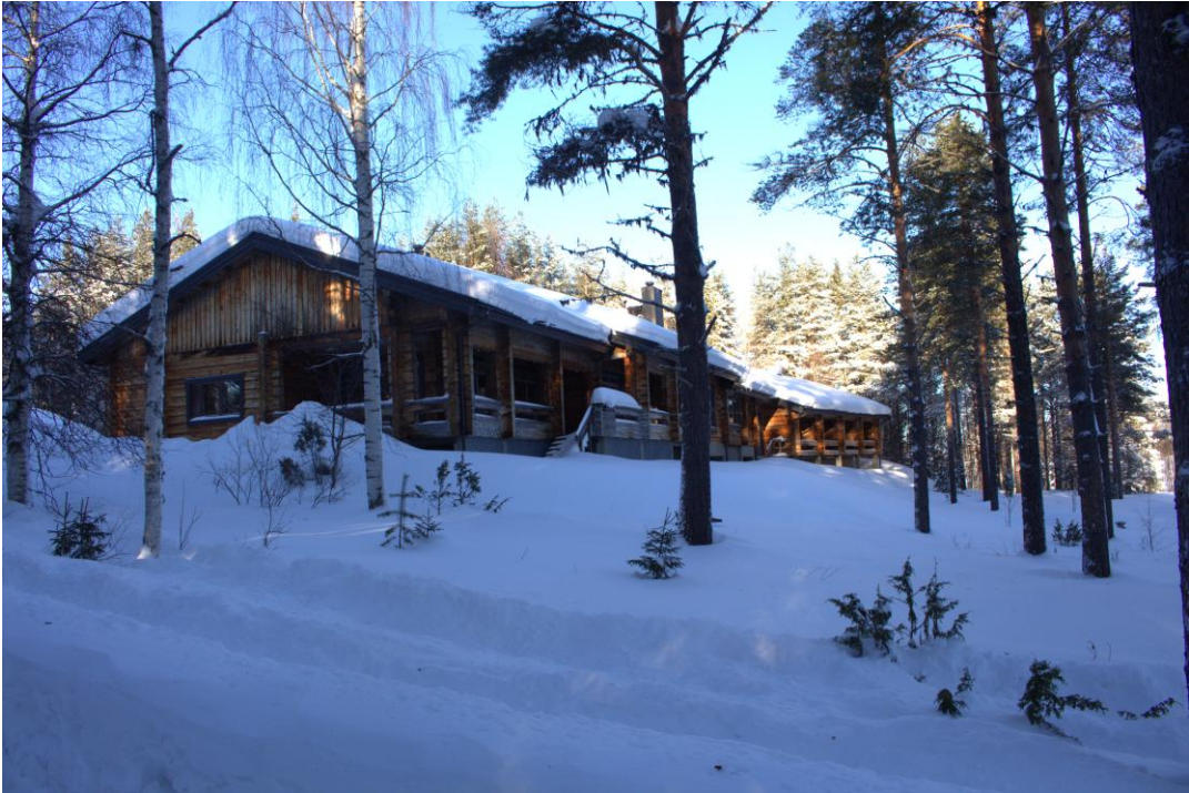
Kuva 12. Hotellirakennus rannan puolelta.
