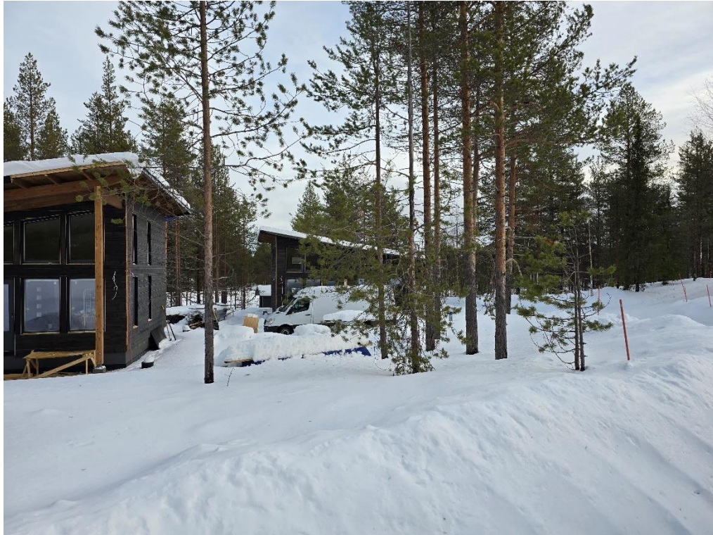
Kuva 8 Rakennuspaikan 1 rakentaminen on edistynyt (Kuva: Kimmo Mustonen, 7.2.2025)
