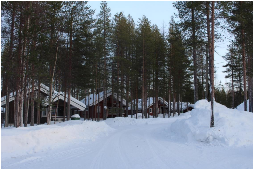
Kuva 16. Suunnittelualueen itäpuolen rakennuskantaa Uusipalon varrella, 23.1.2022.
