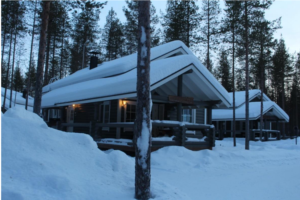
Kuva 17. Suunnittelualueen itäpuolen rakennuskantaa Uusipalon varrella, 23.1.2022.
