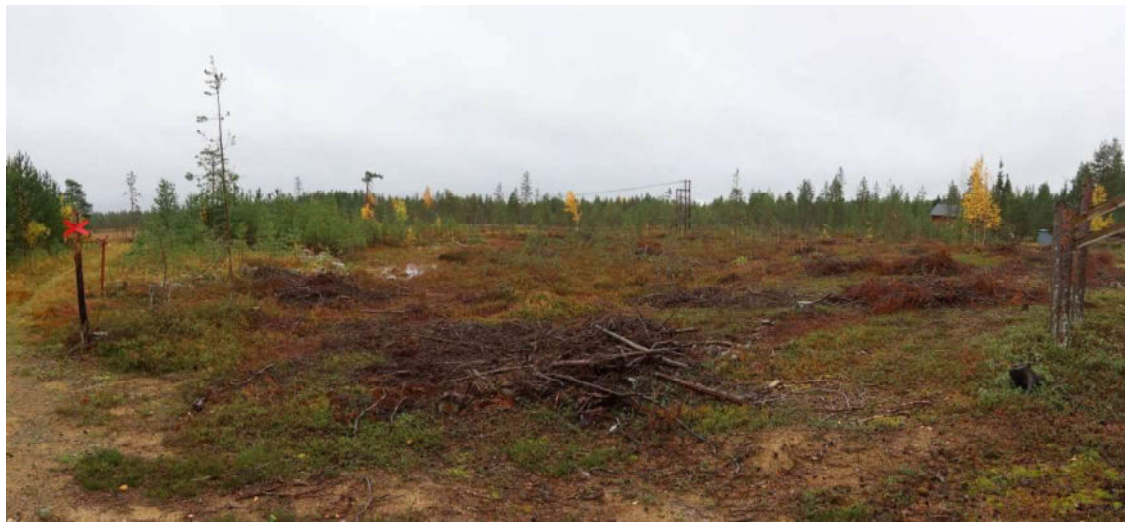
Kuva 2 Rakennuspaikalla on rakentamisen valmistelua aloitettu
