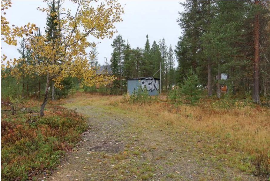
Kuva 5 Alueen eteläpuolella oleva muuntaja ja asuinrakennuksia
