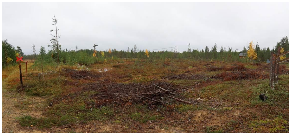
Kuva 2 Rakennuspaikalla on rakentamisen valmistelua aloitettu
