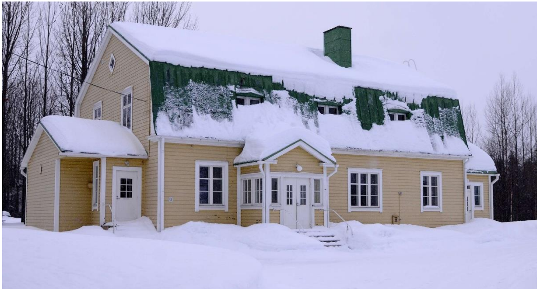
Pappilan päärakennuksen julkisivu pohjoiseen.
