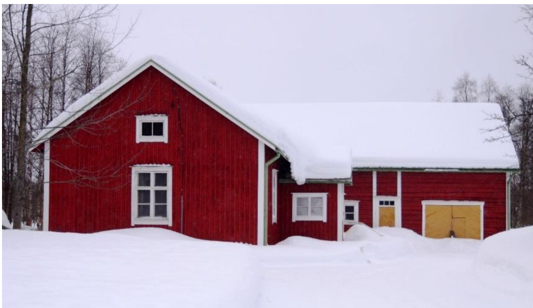
Pappilan pirtti- ja navettarakennus. Julkisivu itään.
