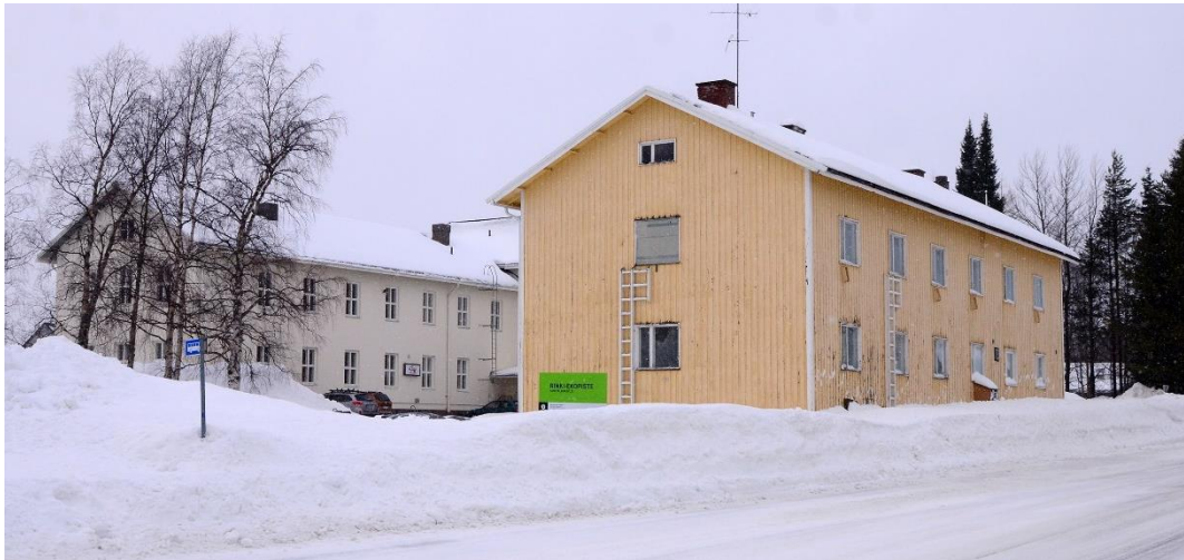
Koulualueen rakennukset muodostavat tunnistettavan kokonaisuuden.
