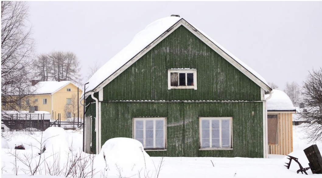
Sodankyläntie 4b:n eteläjulkisivu. Sisäänkäynti on remontissa.
