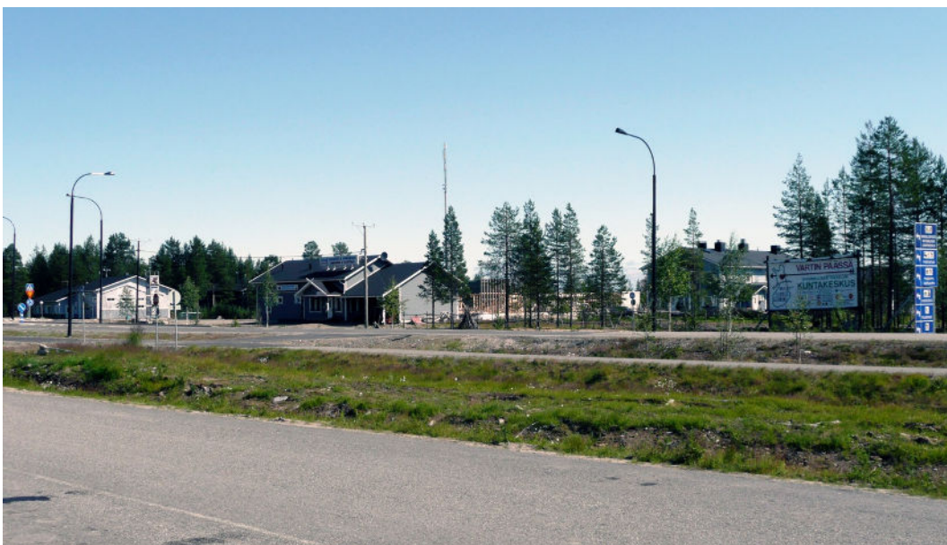
Kuva 17 Pyhäntien itäpuolista rakentamista.
