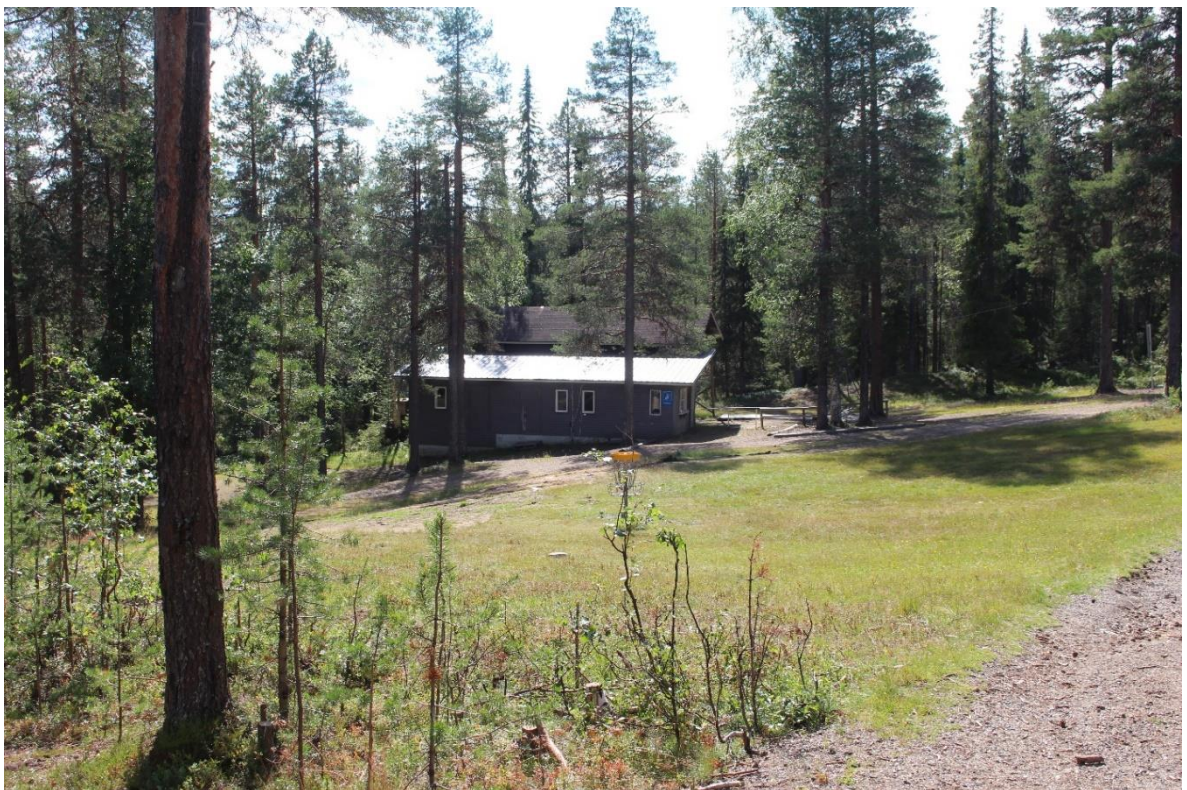
Kuva 9. Käytöstä poistetun hissien ala-asema, joka on tarkoitus purkaa. Uusi laa-haushissi on mahdollista sijoittaa hieman ylemmäksi rinteeseen suunnassa.
